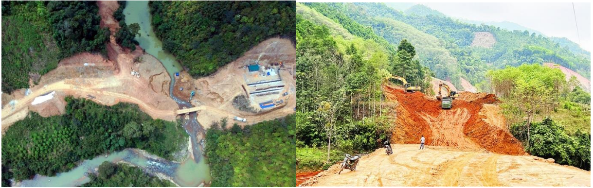
Hình 143. Một số hình ảnh đổ thải khi thi công, san ủi mặt bằng qua xã Bằng Phúc, huyện Chợ Đồn
