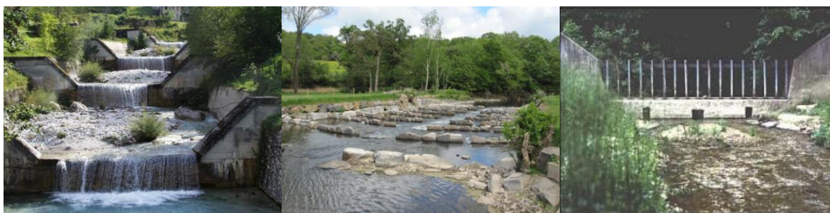
Hình 125. Đập chắn ngang dòng, ngưỡng tràn và đập chắn bùn đá
