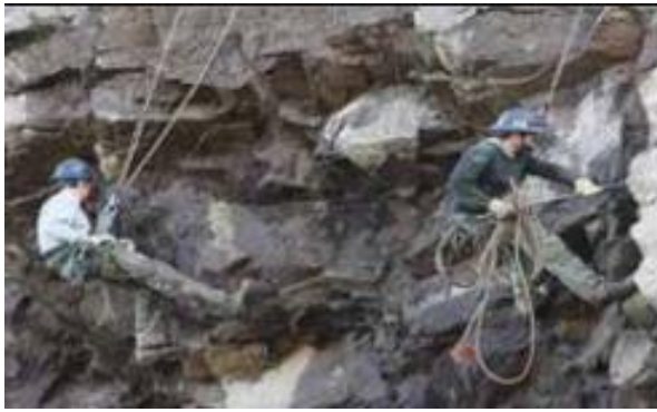
Bóc bỏ phong hoá thủ công
