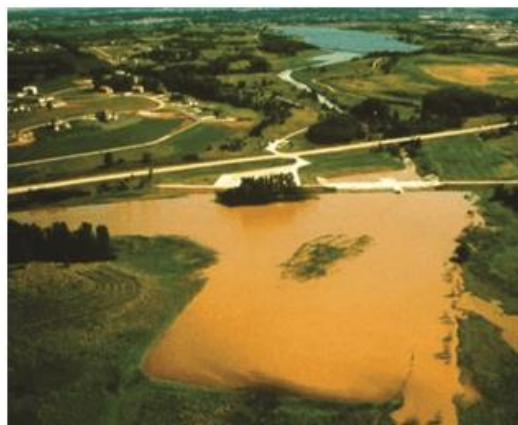
Hình 129. Bể lắng được xây dựng bên trên Hồ chứa Wehrspann, Nebraska
