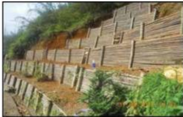
Gia cố mái dốc
