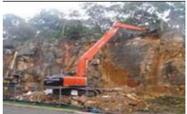
Bóc bỏ phong hoá bằng máy
