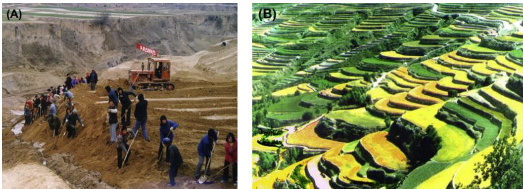
Hình 1. (A) San lấp mặt bằng, và (B) ruộng bậc thang ở tây bắc Trung Quốc
