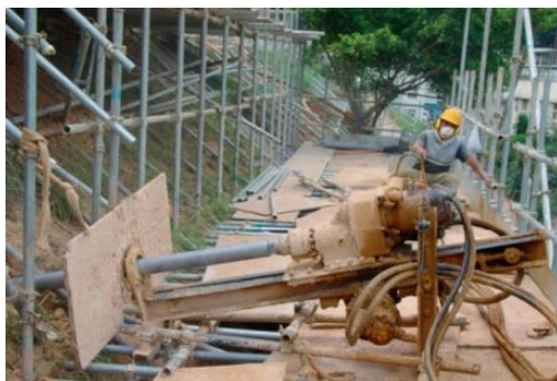
Thi công móng đất ở mái dốc cắt đất
