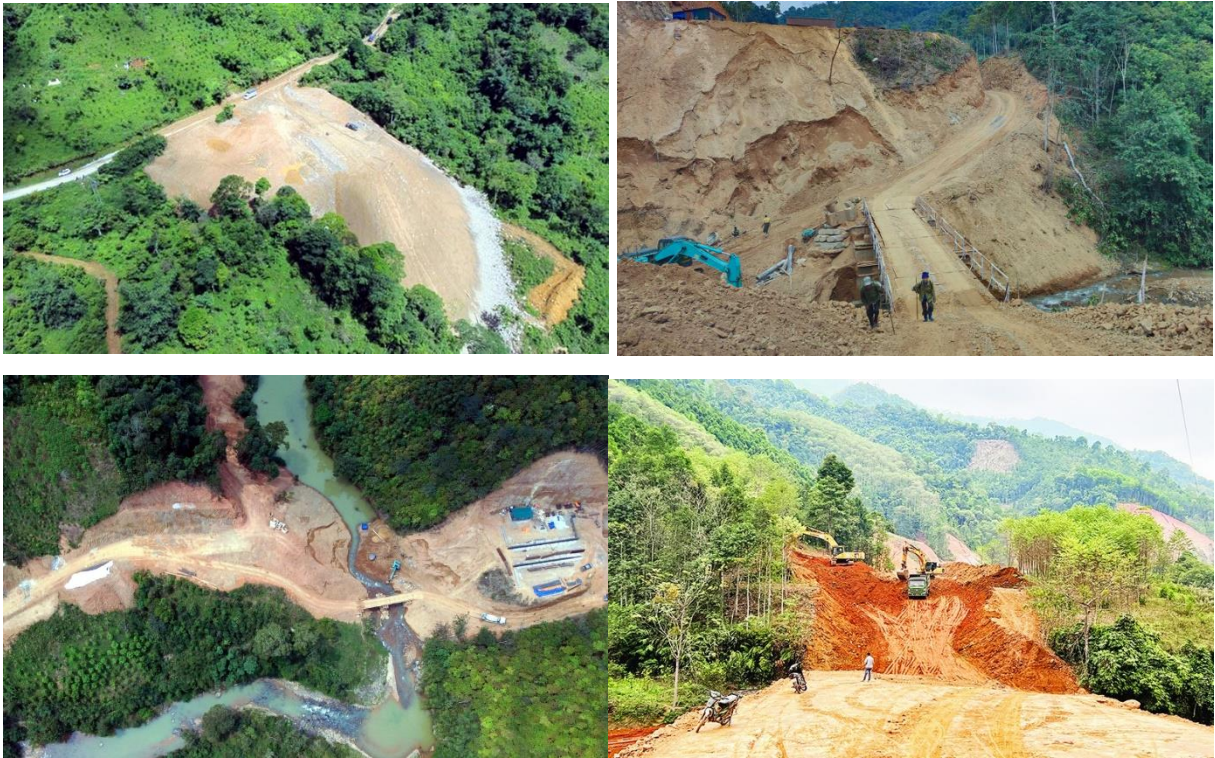
Hình 82. Một số hình ảnh đổ thải khi thi công, san ủi mặt bằng qua xã Bằng Phúc, huyện Chợ Đồn
