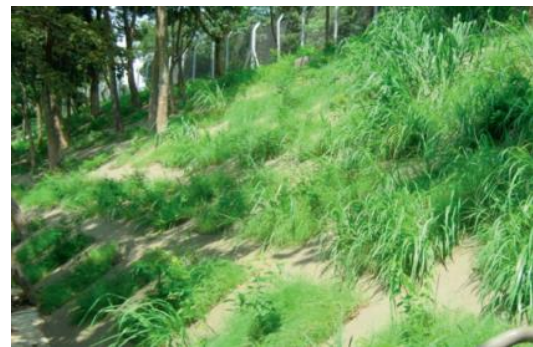
Hoàn thành móng đất và thi công lưới
