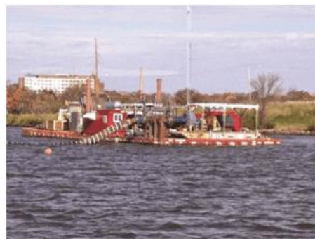
Hình 11. Nạo vét bằng thủy lực tại hồ Decatur, Illinois, Mỹ
