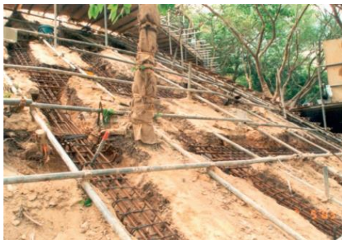
Thi công móng đất và phân
