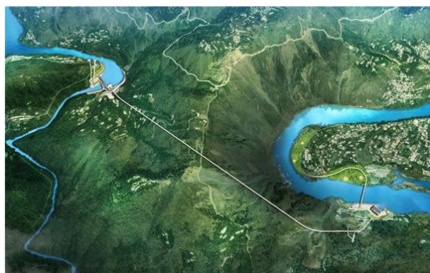
Hình 15. Công trình thủy điện Patrind
