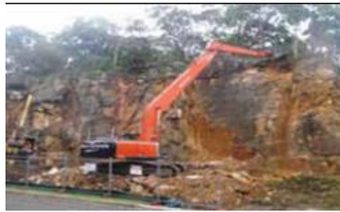
Bóc bỏ phong hoá bằng máy
