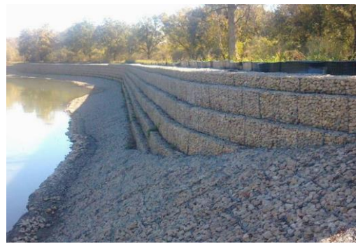
Hình 50. Công trình bảo vệ bờ
