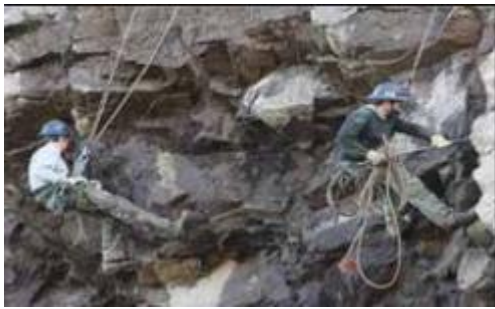
Bóc bỏ phong hoá thủ công
