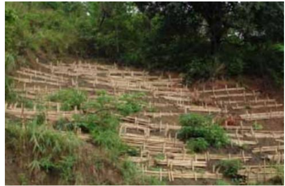
Hình 6. Bậc thang tre, tường cũ tre, đan tre được phát triển để phù hợp với yêu cầu của từng độ dốc
