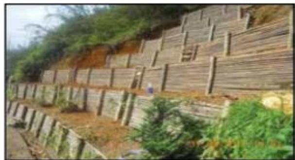
Hình 53. Xây kè taluy để bảo vệ mái dốc
