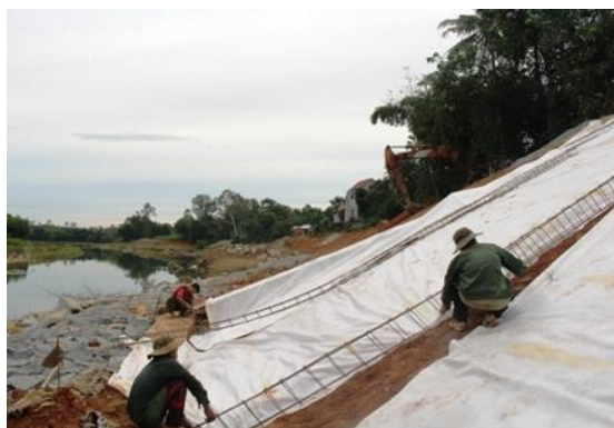
Hình 21. Công trình kè chống sạt lở bờ Nam sông Trà Bồng
