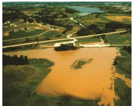
Hình 66. Bể lắng được xây dựng bên trên Hồ chứa Wehrspann, Nebraska
