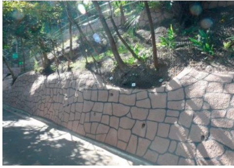
Lớp hoàn thiện giống như gạch xây trên lớp phủ dốc cứng
